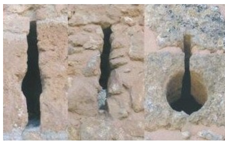
Aspillera 19 , saetera y tronera
